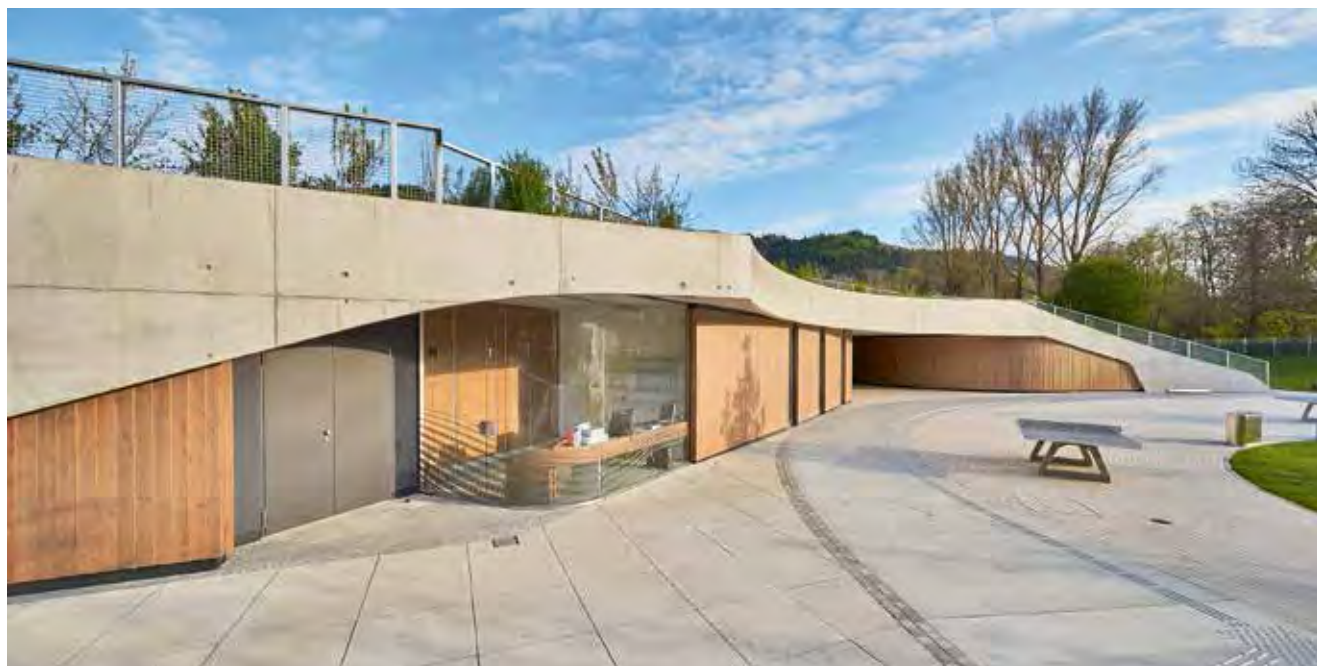
通过霍曼门业的双开门钢质门可以从游泳池一侧进入技术室。隔壁：游泳池技师的办公室。
