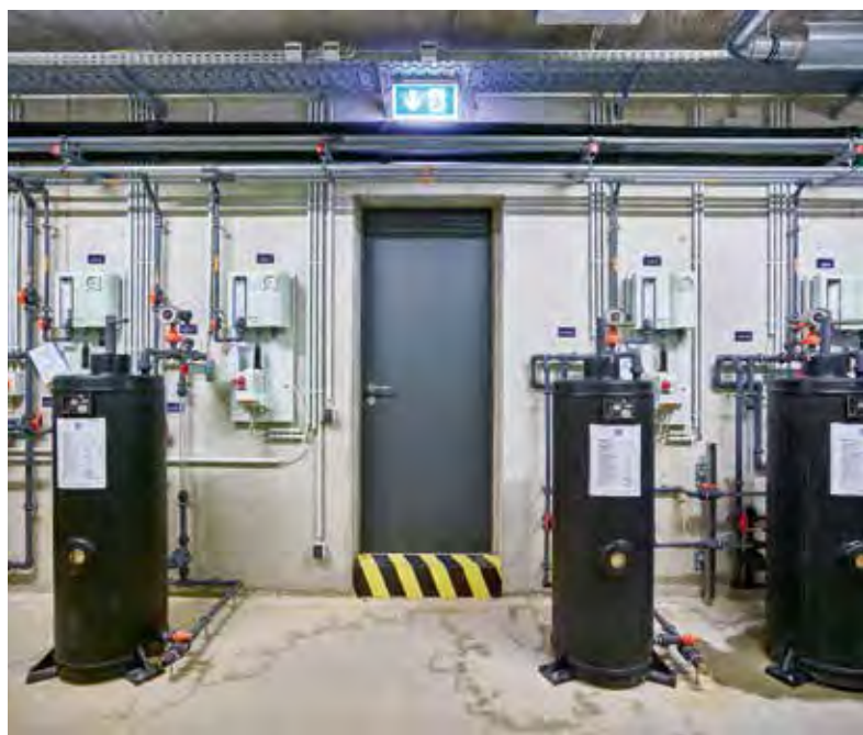
一扇狭窄的通道门从建筑物内部通向技术室。
