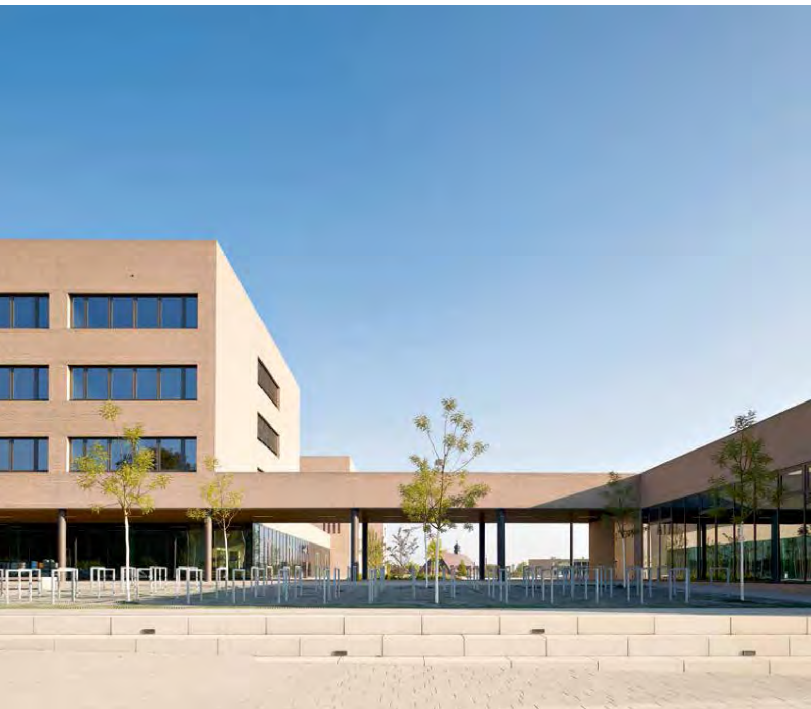
由手工制作的特殊规格石材建成的灰色熟料建筑立面均匀遍布整个建筑物。
